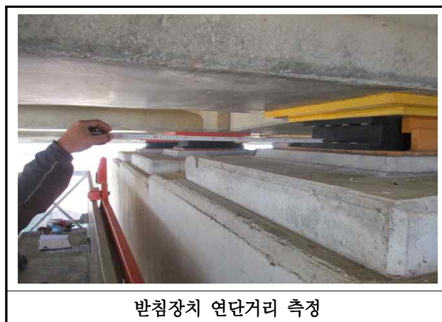
【사진 37.3.37】 교량받침장치 연단거리측정
