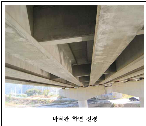
【사진 37.3.25】 바닥판하면 전경
