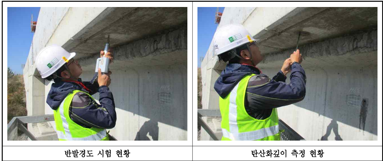
【사진 37.4.1】 콘크리트 내구성조사 현황
