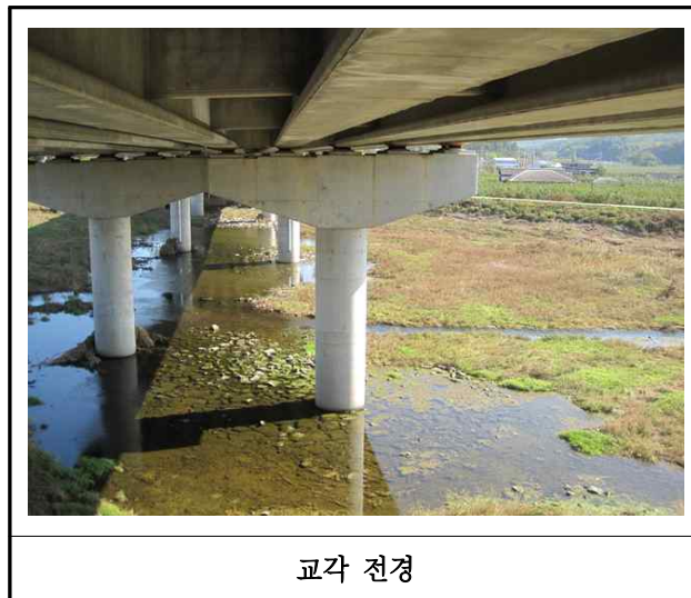
【사진 37.3.33】 교각 전경
