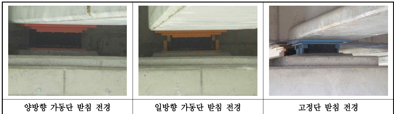
【사진 37.3.35】 교량받침 전경
