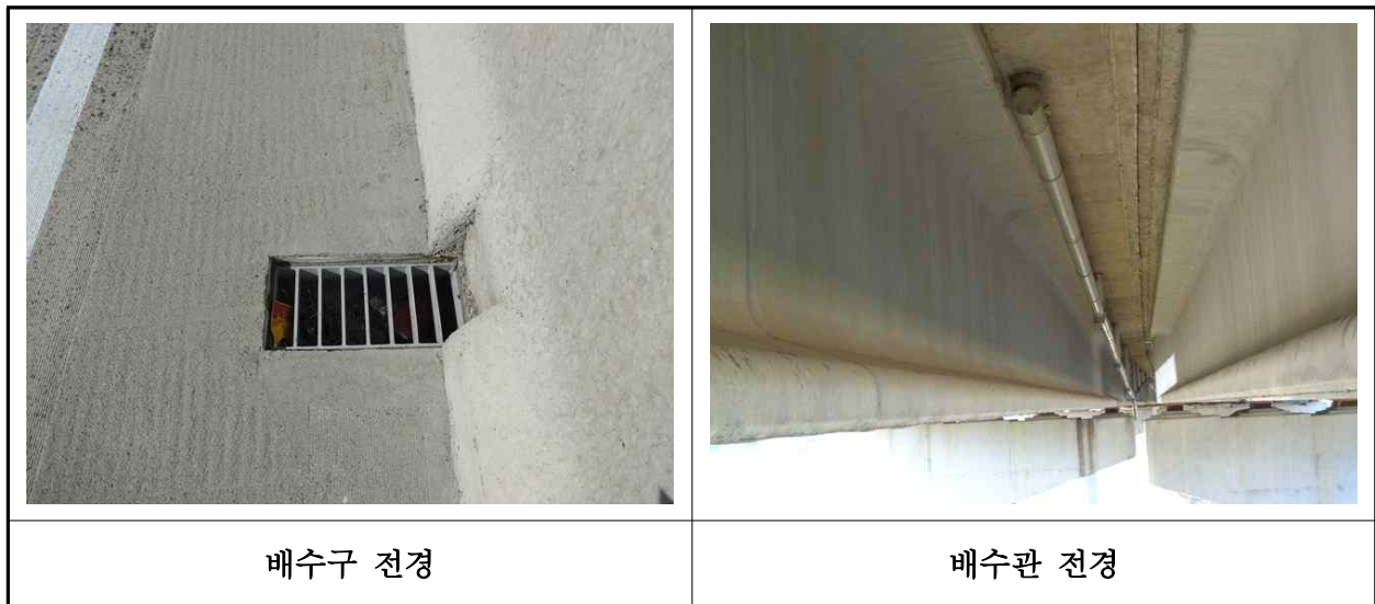
【사진 37.3.44】 배수시설 전경
