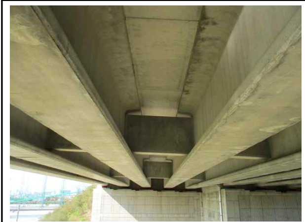
바닥판 하면 상태양호
