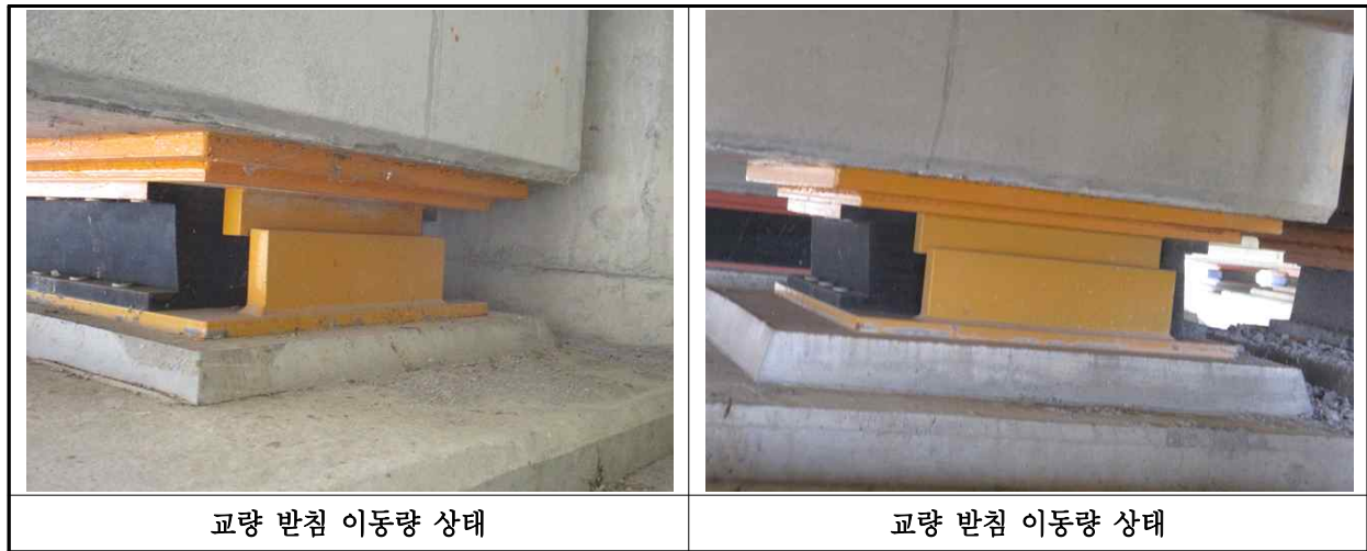
【사진 37.3.38】 교량받침 이동량 측정
