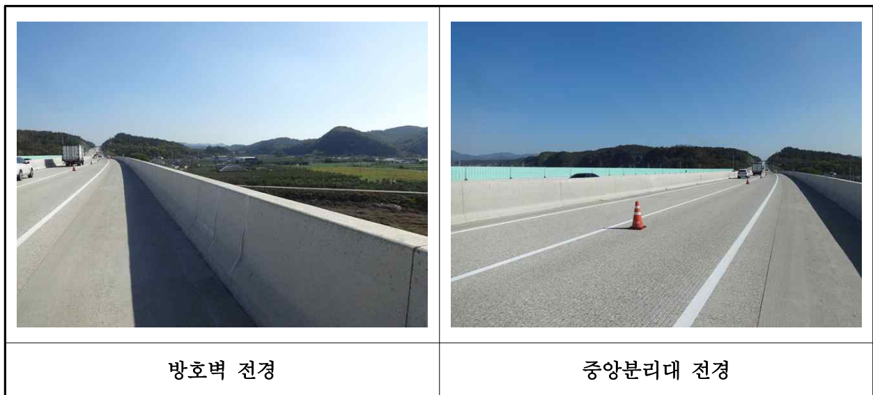
【사진 37.3.45】 방호벽 및 중앙분리대 전경
