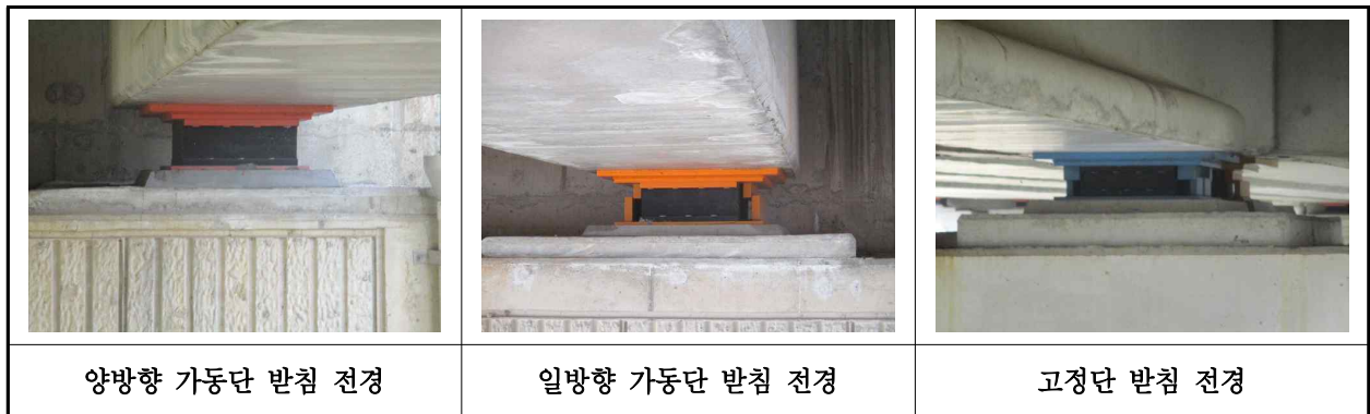
【사진 37.3.12】 교량반침 전경
