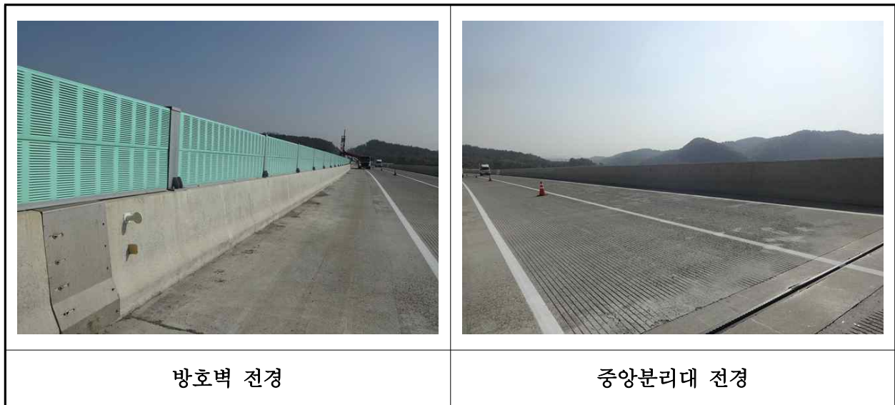
【사진 37.3.23】 방호벽 및 중앙분리대 전경
