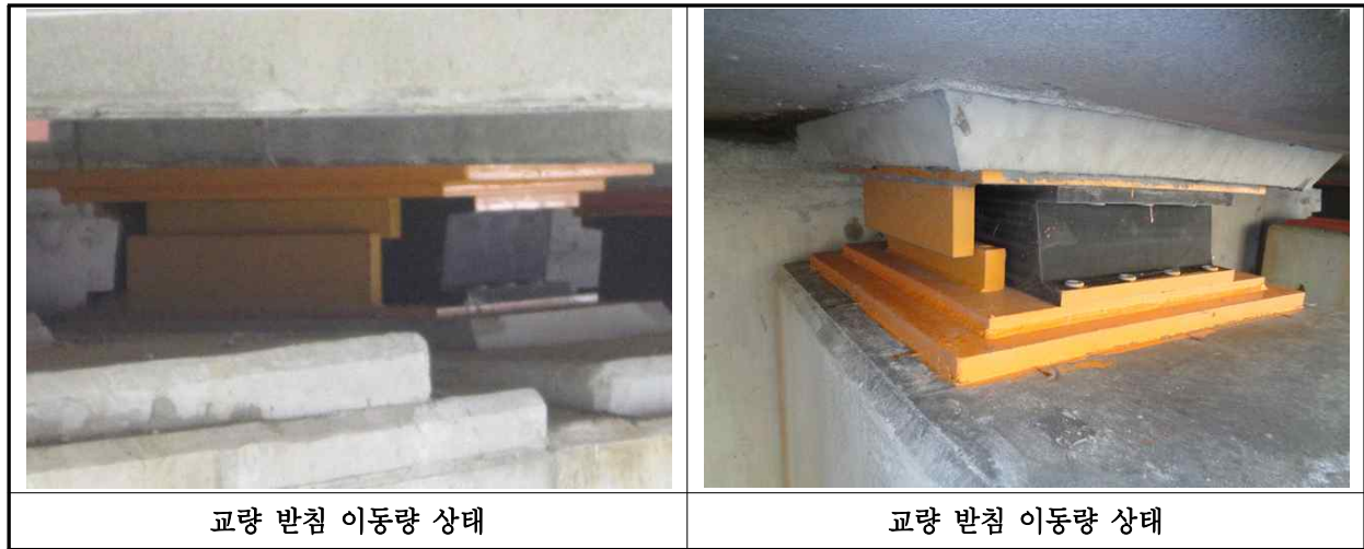
【사진 37.3.15】 교량받침 이동량 측정
