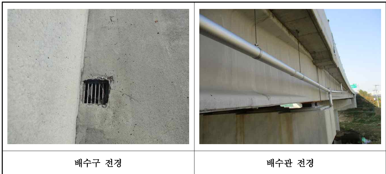
【사진 37.3.21】 배수시설 전경
